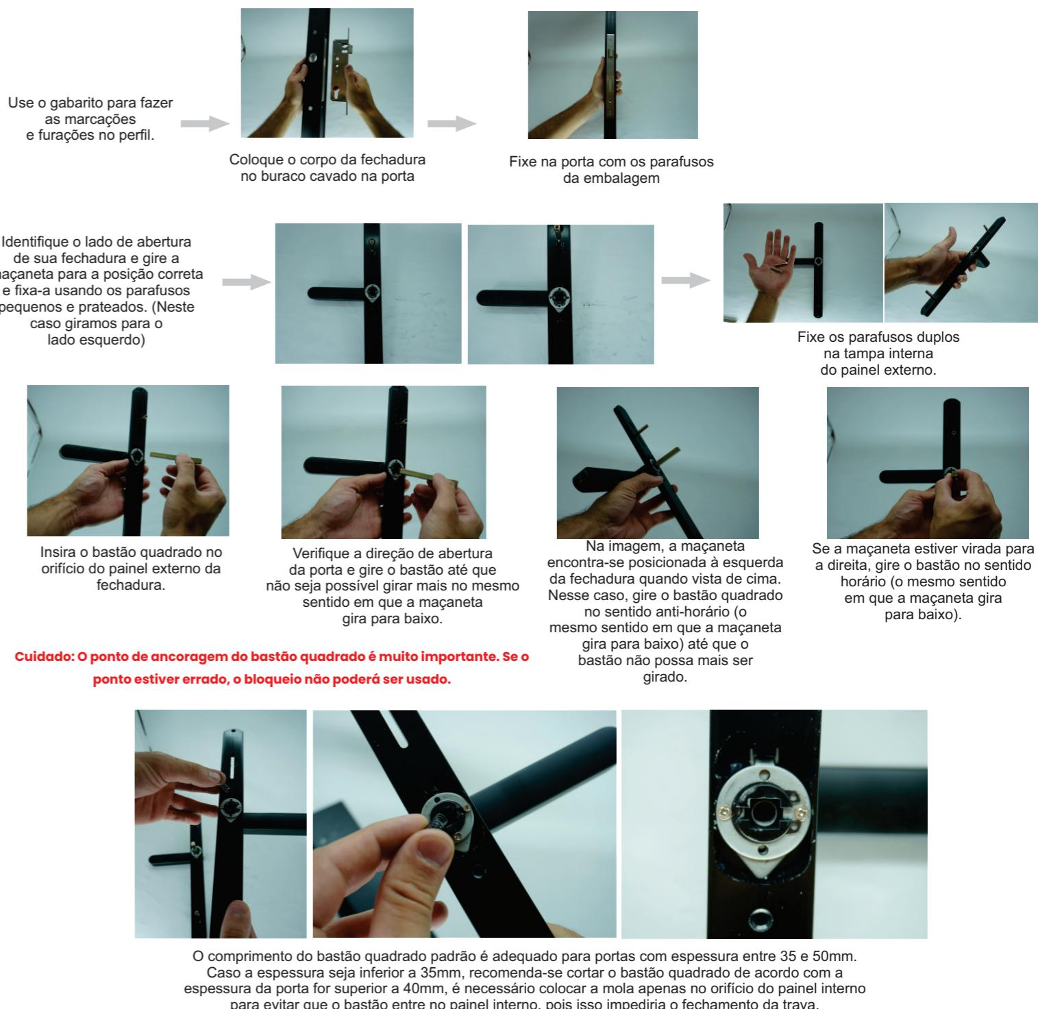
Conecte o painel externo e o painel interno com os parafusos
